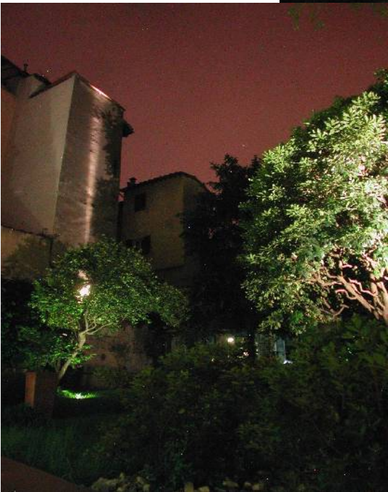
Particolari illuminazione notturna post-intervento
